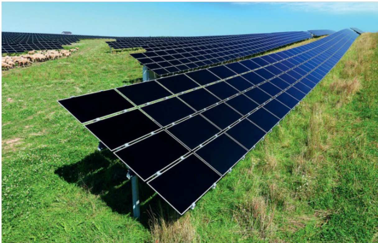
Abbildung 10: [6] Dünnschicht-Module aufgeständert zu Arrays auf Weideflächen für Schafe.
