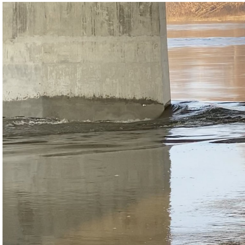
ABB. 2: PFEILER DER LAZIENKI-BRÜCKE IN WARSCHAU BEI HOHEM PEGELSTAND DER WEICHEL. NACH DEM GALILEISCHEN PRINZIP WIRD ALSO EINE GEWISSE MENGE WASSER BEI BEWEGUNG MITGESCHLEPPT.
