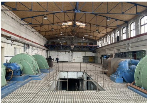
Abb. 1: Turbinenhalle, Ansicht von Haupteingang nach hinten
