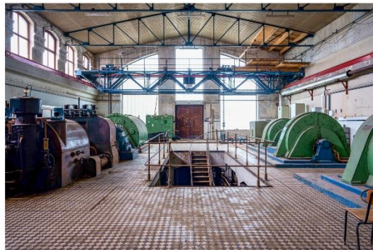
Abb. 2: Turbinenhalle, Ansicht zu Haupteingang nach vorne
